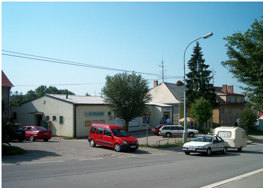
Téměř oproti prodejně Jednoty v Černé staví Obec nový bytový dům.
