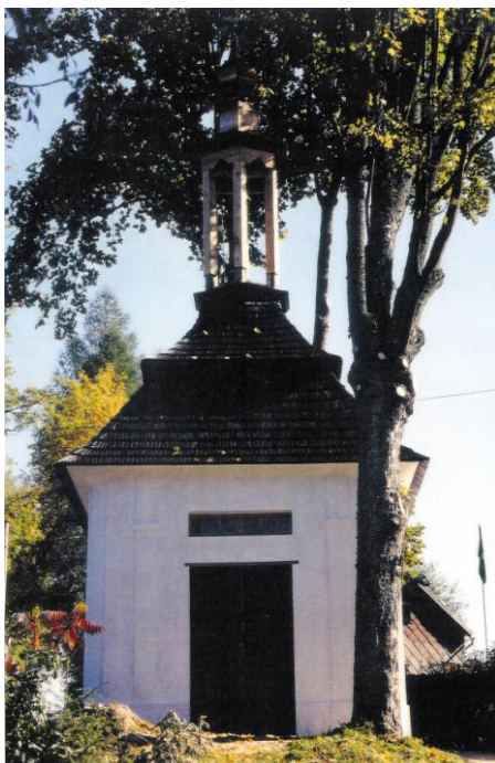
Kaplička na Radslavi po celkové opravě v r.1999.
