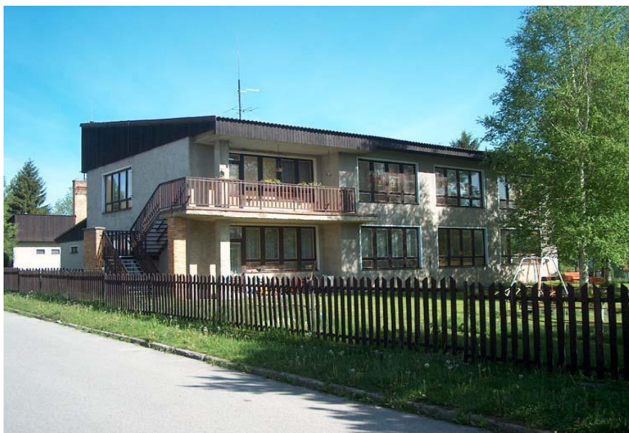
Budova Mateřské školy v Černé v Pošumaví.
