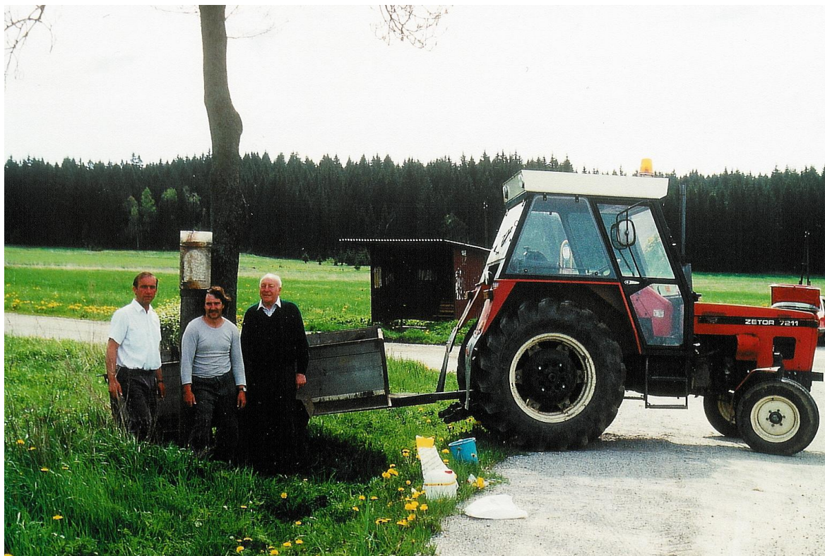
Výstavba kříže u zastávky Muckov.
