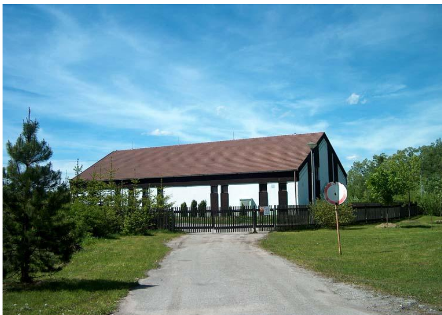
Čistírna odpadních vod v Černé v Pošumaví.
