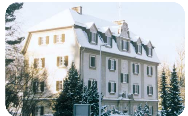
alte Zollamtgebäude im Lackenhaus, stará celnice v Lackenhaus, the old Lackenhaus's customhouse
