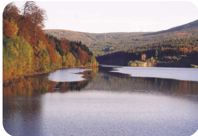
nádrž pitné vody Frauenau, Trinkwassertalsperre Frauenau, Drinking water reservoir Frauenau
