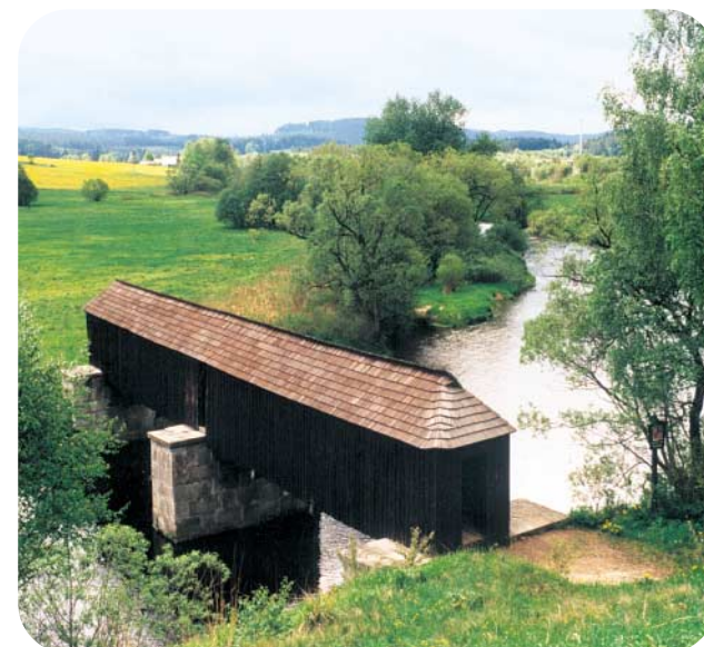
rechle v Lenoře, Rechenbrücke über den Fluss Moldau, the rake bridge on the river Vltava,
