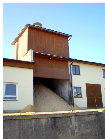
Obr. 13 Silo na piliny
