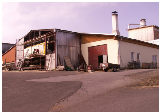
Obr. 2 Pila Černá - rekonstrukce
