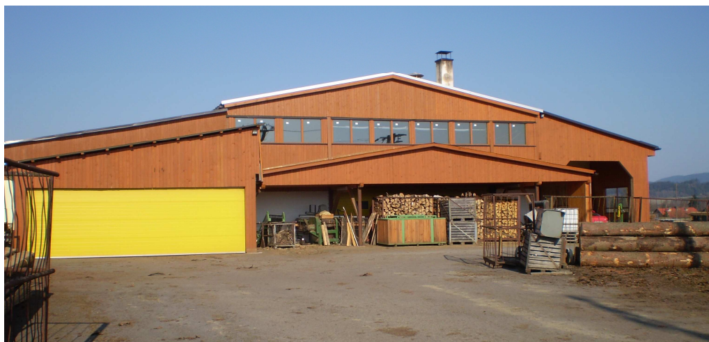
Obr. 3 Pila Černá – po rekonstrukci
