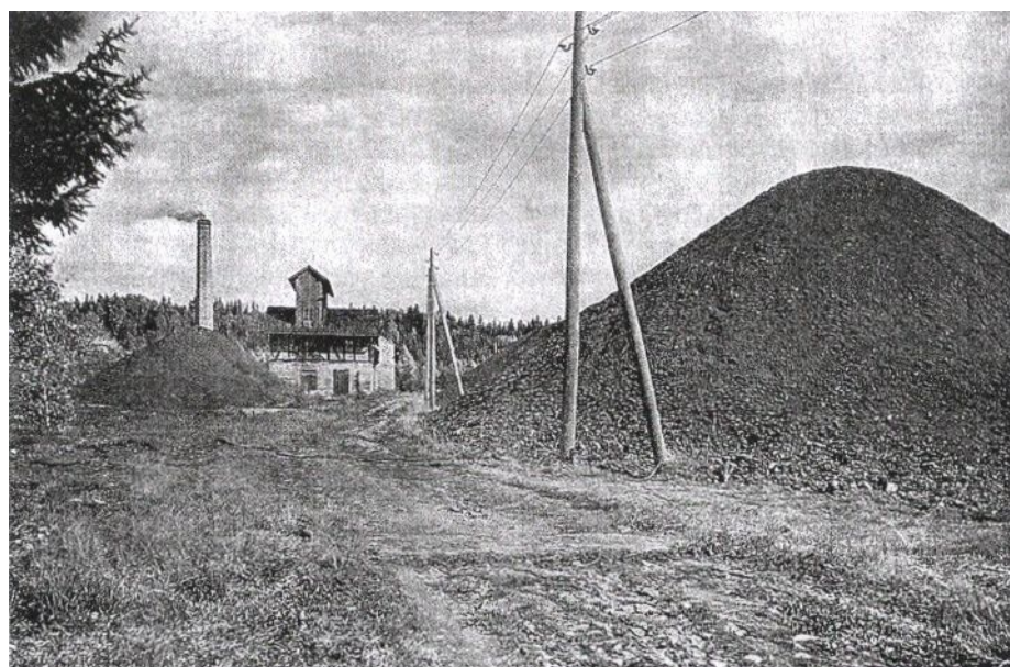
Obr. 17: Stará šachta západně od Mokré na počátku 20. století (převzato: Cícha, 1999).
