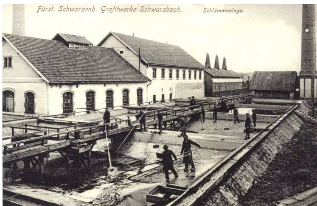
Obr. 23: Plavení tuhy ve speciálním zařízení, 1915 (převzato: Karpaš, Zálaha, 2001).
