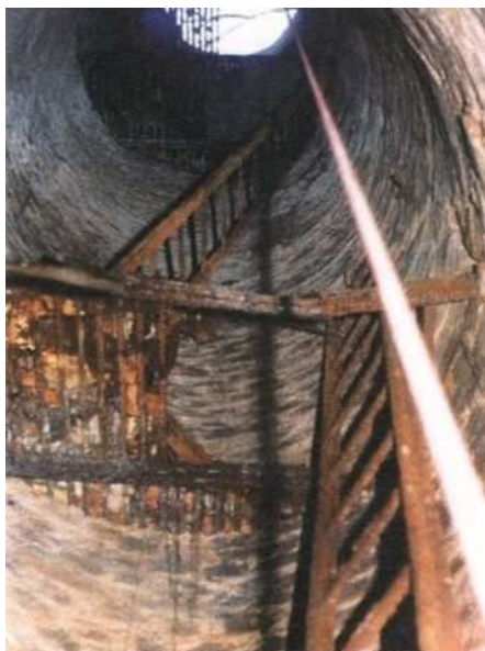
Obr. 25: Grafitové doly u Mokrý, Ferdinandova šachta se zbytky železných žebříků a povalů (převzato: Cícha, 1999).
