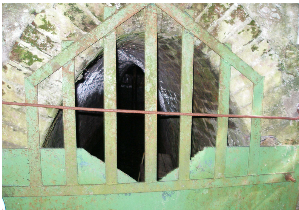
Obr. 33: Pohled do uzamčené Josefovy dědičné štoly (foto K. Milichovská, 2006).
