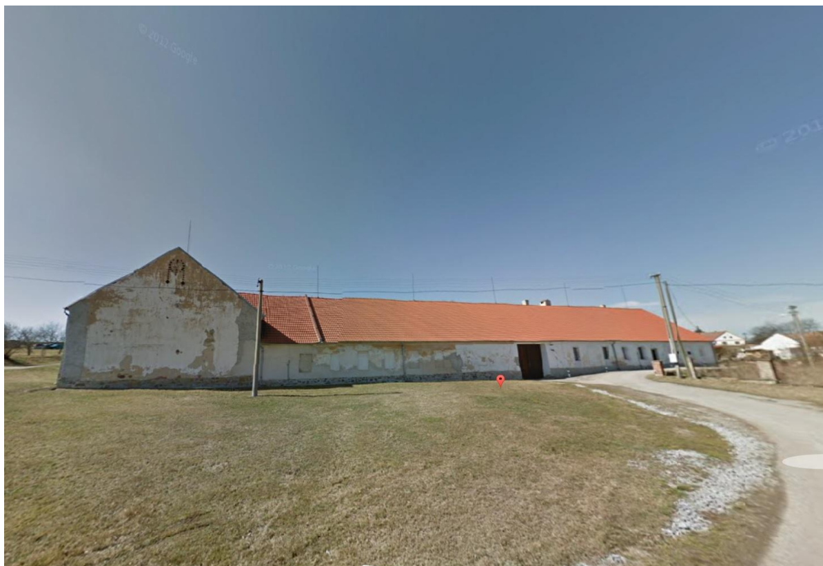
Pohled na budovy firmy STATEK DVOŘÁK,s.r.o. v Čeřejově - / mapy Google/
