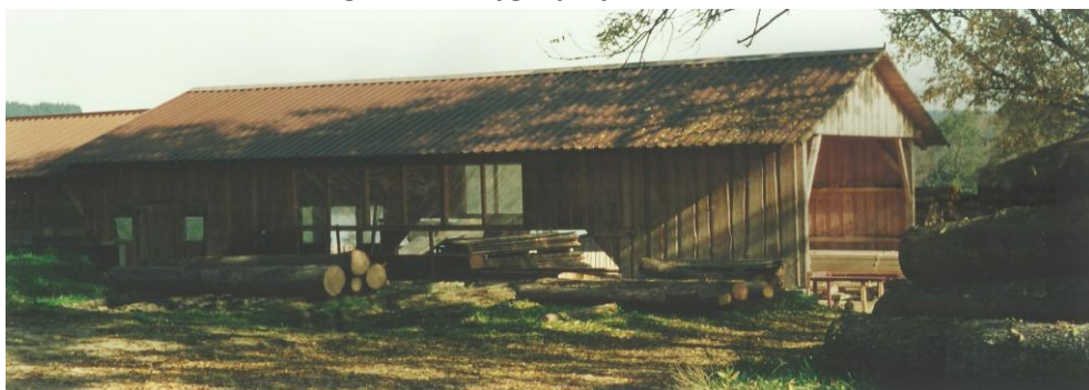
Hotový přístřešek pro katr
