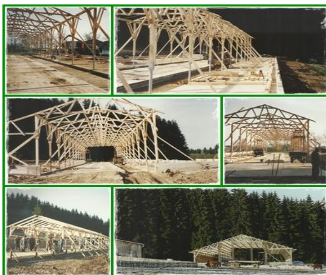
Výstavba teletníku pro 200 ks telat byla dokončena v roce 2002
