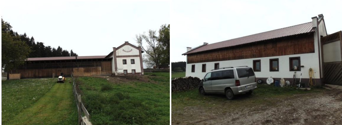
Spodní pohled na hospodářskou budovu a dílnu
