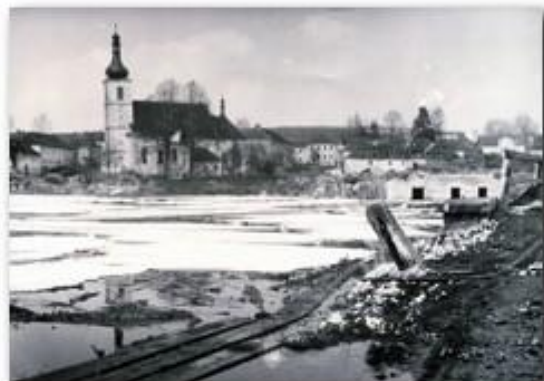
Dolní Vltavice – postupná demolice po r.1956
