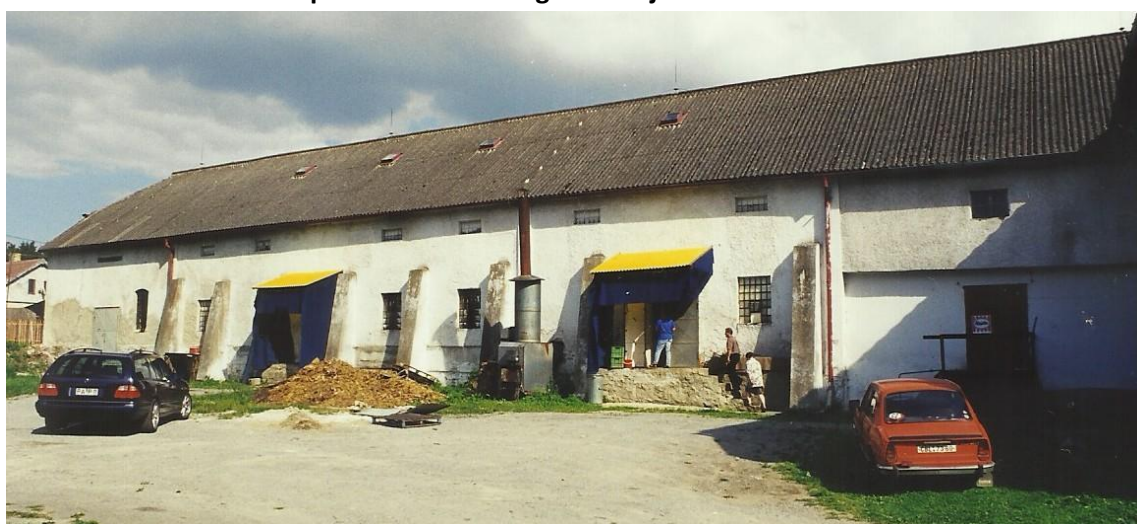
Začíná rekonstrukce budovy
