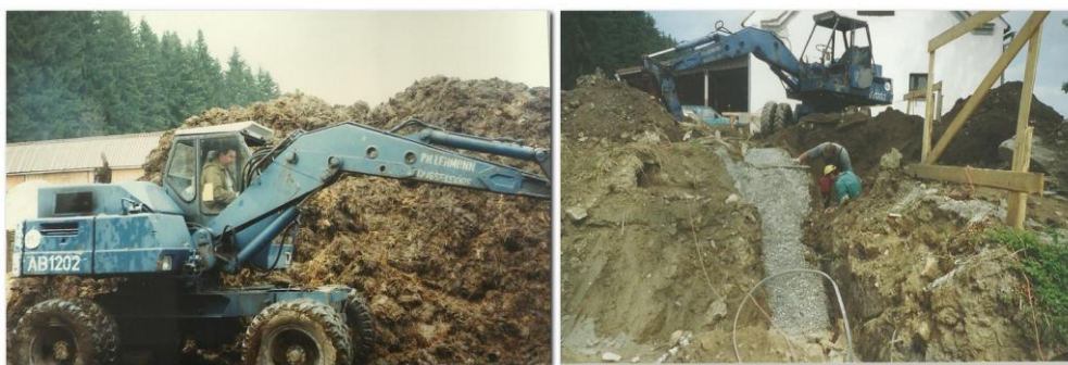
Při výstavbě farmy, úpravě a nakládání hnoje a dalších pracích se využil kolový bagr
