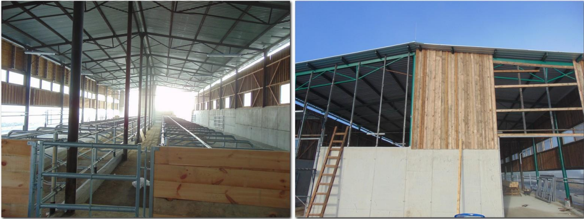
Stavba na Muckově se blíží ke svému závěru, termíny by měly být dodrženy (foto 17.9)
