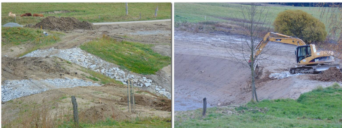
Zpevnění kamenivem a úprava svahů zatím stále pokračuje / 5.11/
