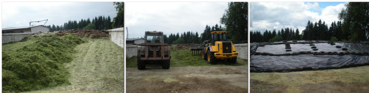
Senážní jáma na Muckově ve fázi rozpracování a ukončení / foto 12.6+ 16.6/
