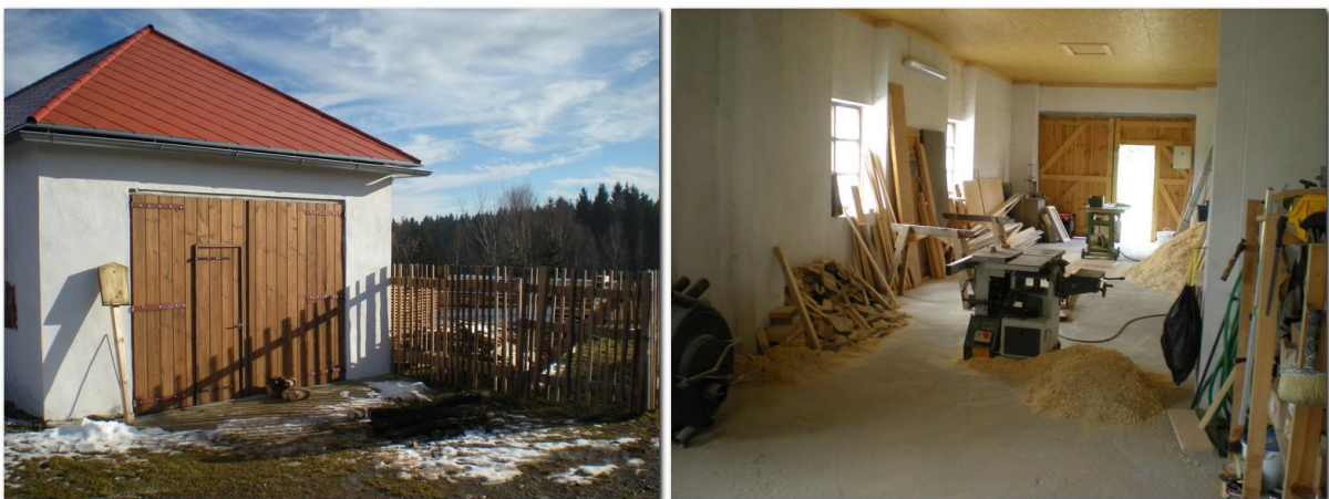
Bývalá dílna, kterou firma převzala ještě po Státním statku Frymburk, byla rekonstruována na potřebnou truhlárnu
