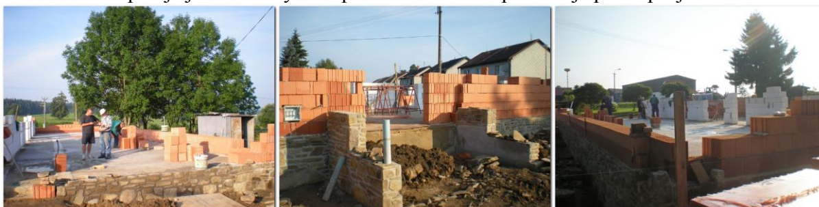
Hotovy jsou i vnitřní podlahy celkové stavby /7.8.2014/
