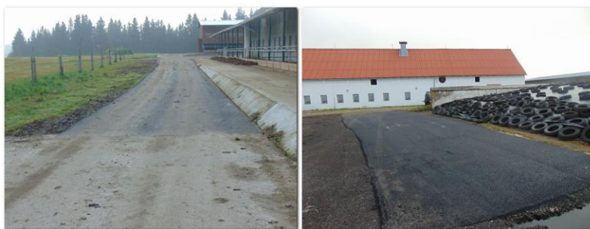
Koncem října se povedlo částečně zpevnit některé plochy na Muckově – okružní cesta kolem stáji a zpevněná plocha před senážním prostorem / 15.11/
