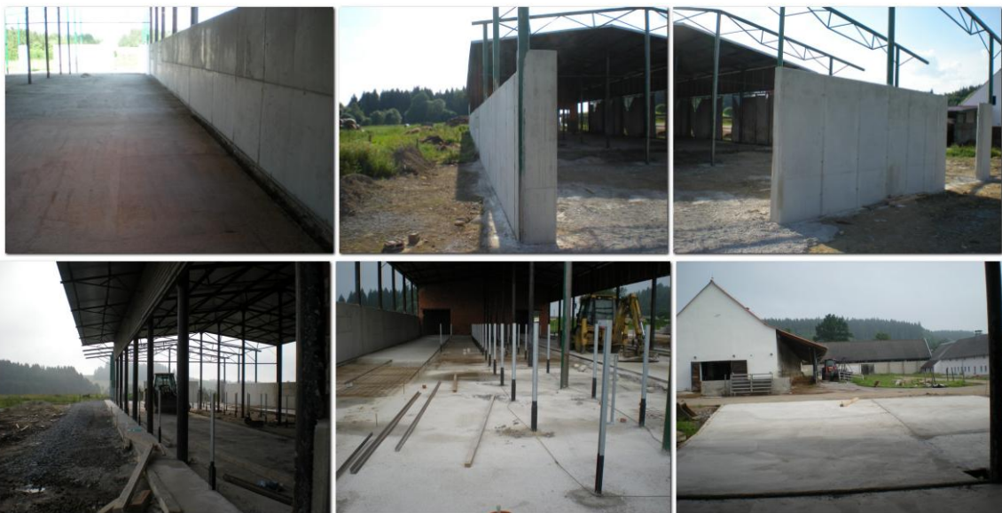
Postup výstavby v měsíčním intervalu. Poslední tři snímky jsou z 28.července, předchozí tři z 27.června 2014
