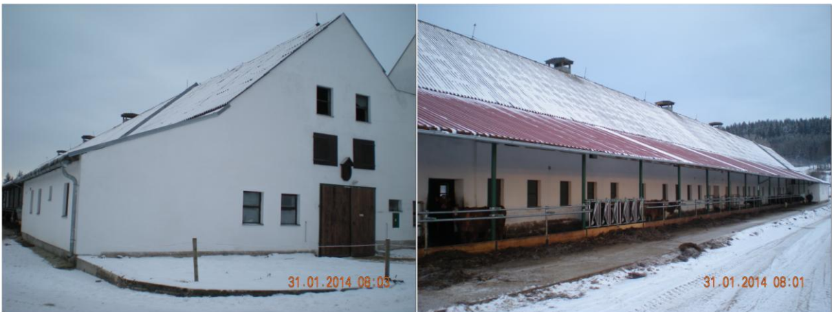
Jako poslední byla rekonstruována stáj skotu na provoze Muckov
