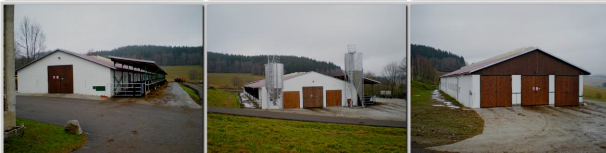
Dvojitý pohled na rekonstruované malšínské stáje
