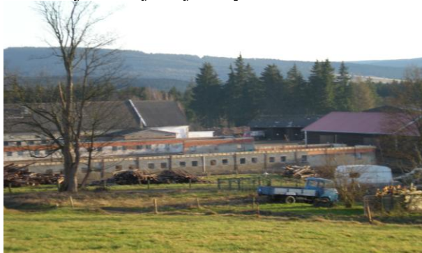
Koncem listopadu 2009 byly postaveny obvodové zdi
