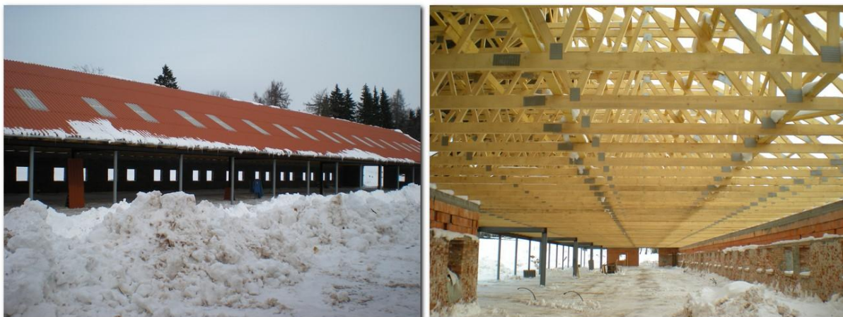
V polovině února 2010 byla na stáji č.1 již nová střecha a na stáji č. 2 krov
