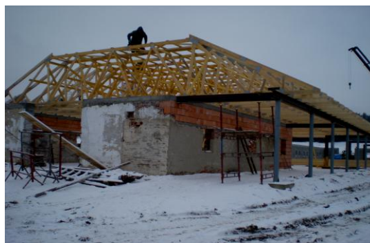
V polovině prosince 2009 se montoval krov
