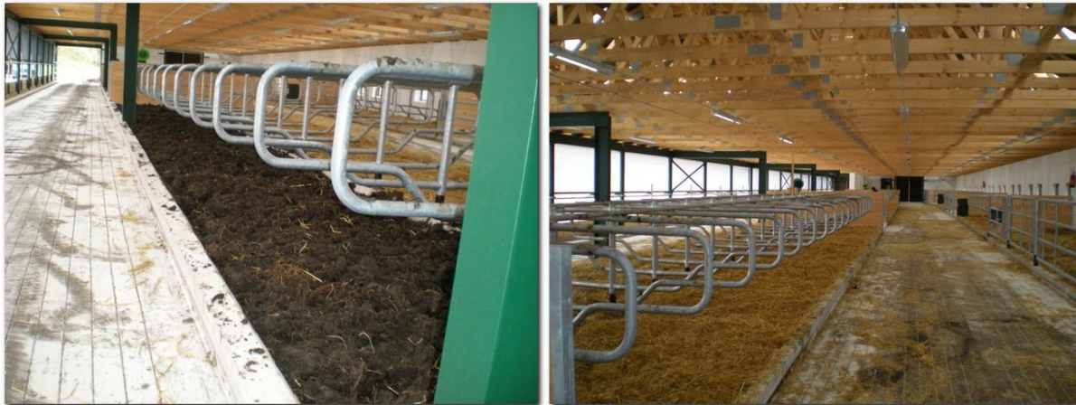
Na ložnou plochu se nejprve rozvrstvil uležený chlévský hnůj, který vytváří tepelnou izolaci Na rozvrstvený hnůj se uložila vrstva slámy
