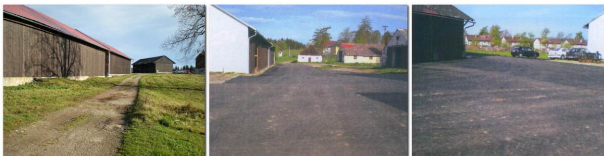
Pohled na původní cestu a vyasfaltovaný areál zemědělských objektů
