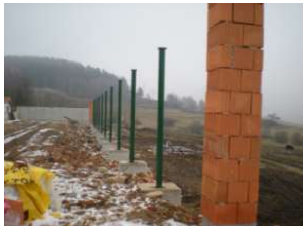
Část levé obvodové zdi byla ponechána a nově dozděna, na pravé straně již vyrostly zabetonované sloupy / foto 17.2. 2010 – F.Z./
