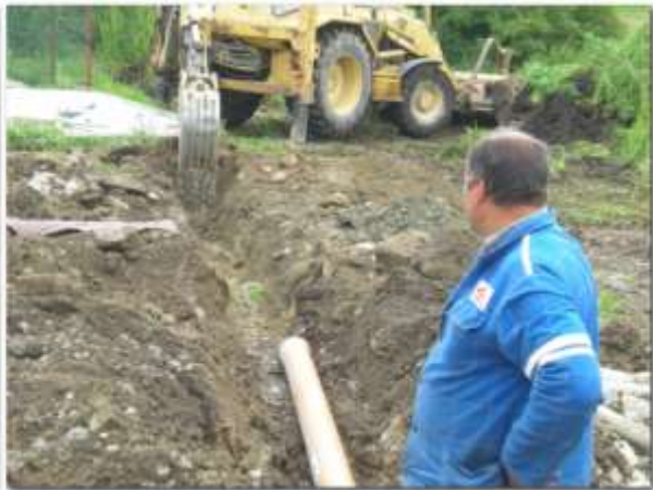
Prostor pod betonovou zakrmovací plochou pod stájí č.2 bude až ke svahu rovněž zpevněn Mistr firmy J+K p. Tourek dohlíží na práce při pokládání kanalizace a její napojení na jímky
