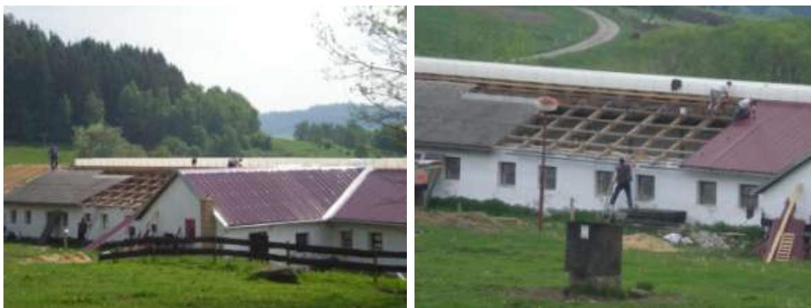
Na stáji č. 1 se především dokončuje střešní konstrukce
