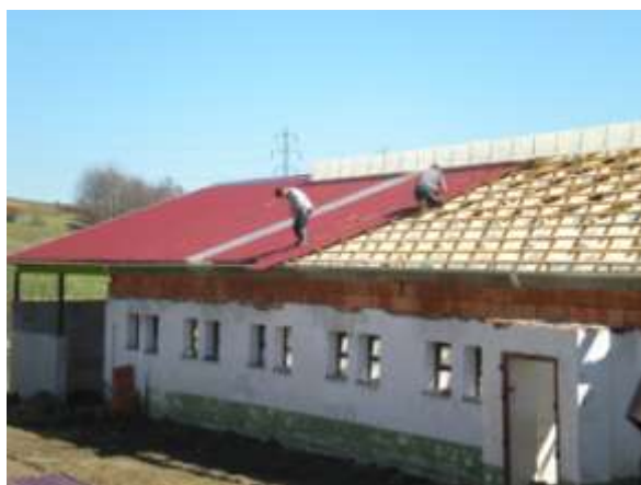
Na stáji č. 3 se nyní pokládá nová střecha, ze spodní strany je již hotova a na druhé straně se právě pracuje – foto 7.4 – F.Z/
