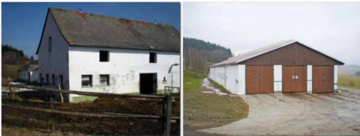
Stáj č. 3 – bývalý teletník
