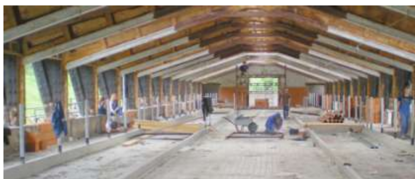
Nejvíce práce zbývá dodělat na stáji č.2, kde s úklidem, vybouráním a dalšími pracemi pomáhají brigádníci /F.Z. – 26.7.2011/
