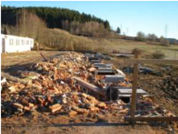
Demolice pokračuje, připravují se patky na zabetonování sloupů a současně se vzadu staví hnojná koncovka / foto 17.1.2011 – F.Z./
