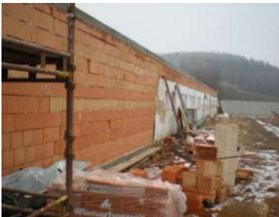
Část levé obvodové zdi byla ponechána a nově dozděna, na pravé straně již vyrostly zabetonované sloupy / foto 17.2. 2010 – F.Z./
