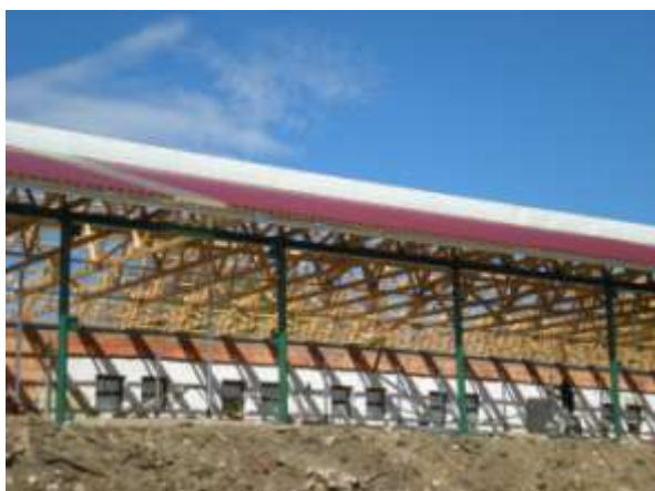
Na stáji č. 3 se nyní pokládá nová střecha, ze spodní strany je již hotova a na druhé straně se právě pracuje – foto 7.4 – F.Z/
