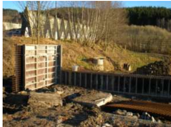
Demolice pokračuje, připravují se patky na zabetonování sloupů a současně se vzadu staví hnojná koncovka / foto 17.1.2011 – F.Z./
