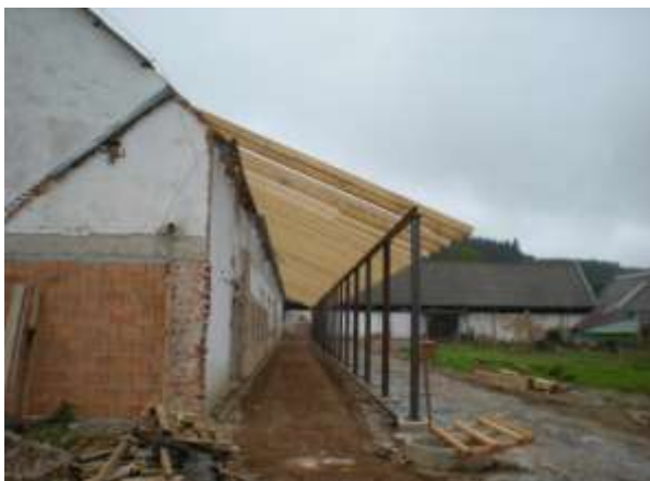
Ve stáji na Muckově vyrostl směrem do dvora přístřešek Uvnitř připravené zábrany čekají na zabetonování
