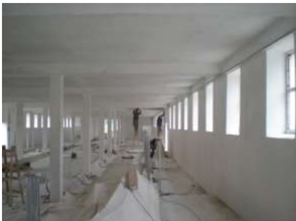
Stáj č. 3 je již vybělená, dokončují se poslední úpravy, odstraňuje se zakrývací fólie ( 6.8-F.Z.)
