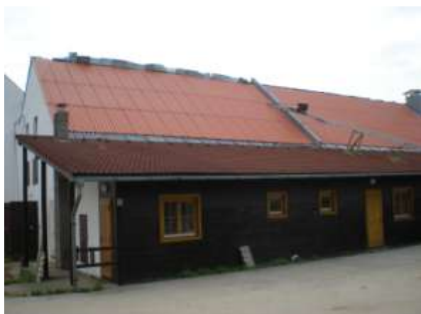
Střecha z jedné strany je hotova
