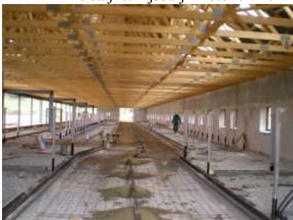
Ve stáji č. 1 jsou již hotové vnitřní levé omítky a vnitřní podlahové betony
