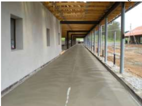
Ve stáji č. 1 jsou již hotové vnitřní levé omítky a vnitřní podlahové betony
