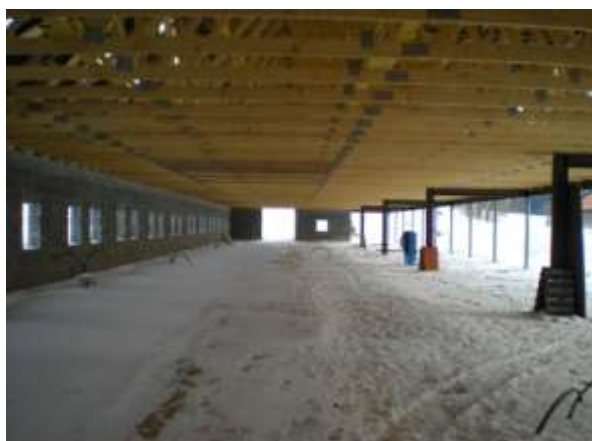
Stáj č. 1 - vnitřek
