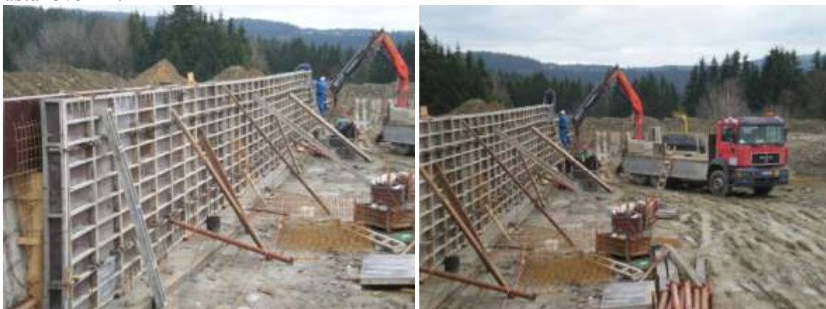
Výstavba pevné konstrukce levé strany žlabu začala právě v těchto dnech / 12. 4. - F.Z./
