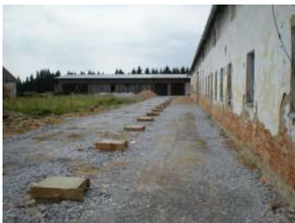
Zabeton. patky a zpevněný povrch zvenku
