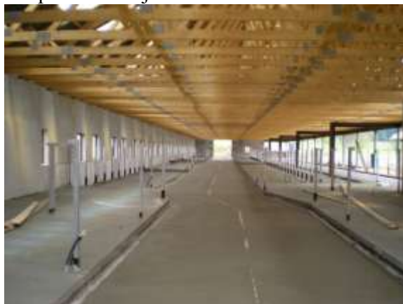
Ve stáji č. 1 jsou již hotové vnitřní levé omítky a vnitřní podlahové betony
