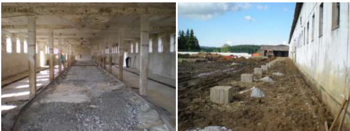
Rekonstrukce pokračuje i v bývalém kravíně č. 3, jak uvnitř, tak i zvenku / levá strana při čelním pohledu – F.Z. 23. 6.
