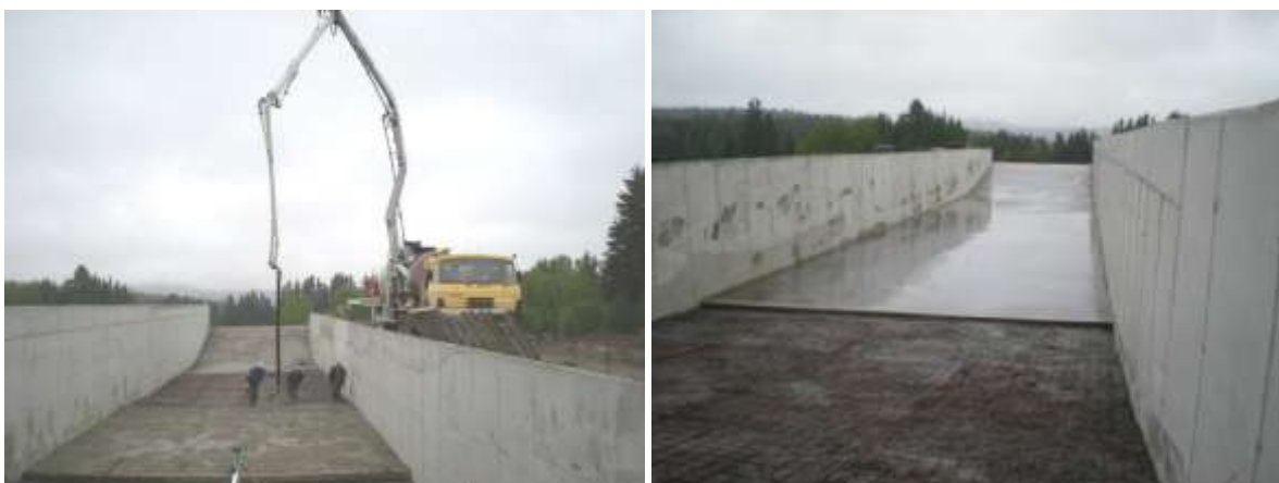
Silážní žlab na Milné má již hotovy postranní opěrné zdi a dodělávají se vnitřní podlahy. Na prvním snímku probíhá betonování v pravém žlabu, dále je vidět ze tří čtvrtin hotový levý žlab / foto F. Z. 2. 6. 2010/
