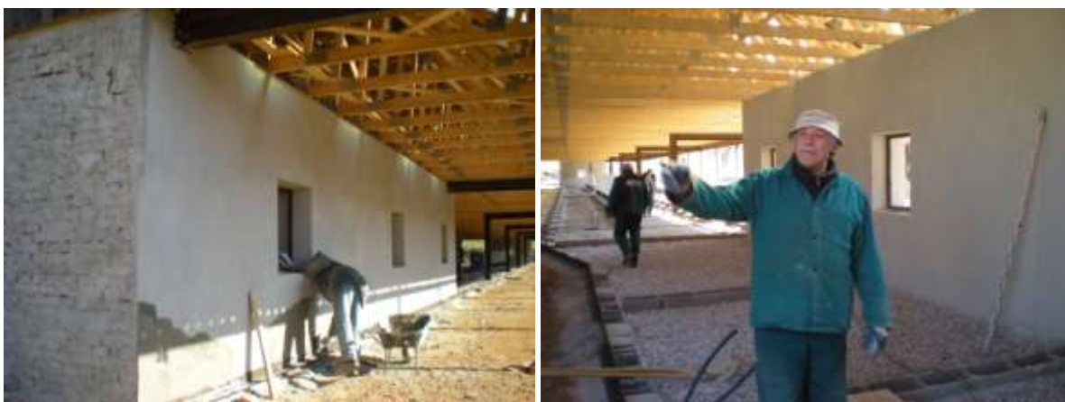
Ve stáji č. 1 se provádí omítky, stejně tak i ve stáji č. 2, jak ukazuje pracovník firmy FAO-Zdeněk Jakeš / foto 22.4. – F.Z./
