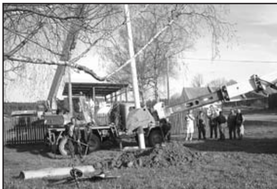
Při vztyčování musela vypomoci i těžká technika.
