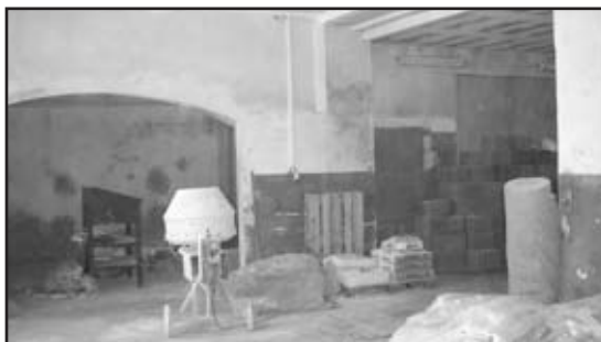
Takhle se s rekonstrukcí začínalo ...
