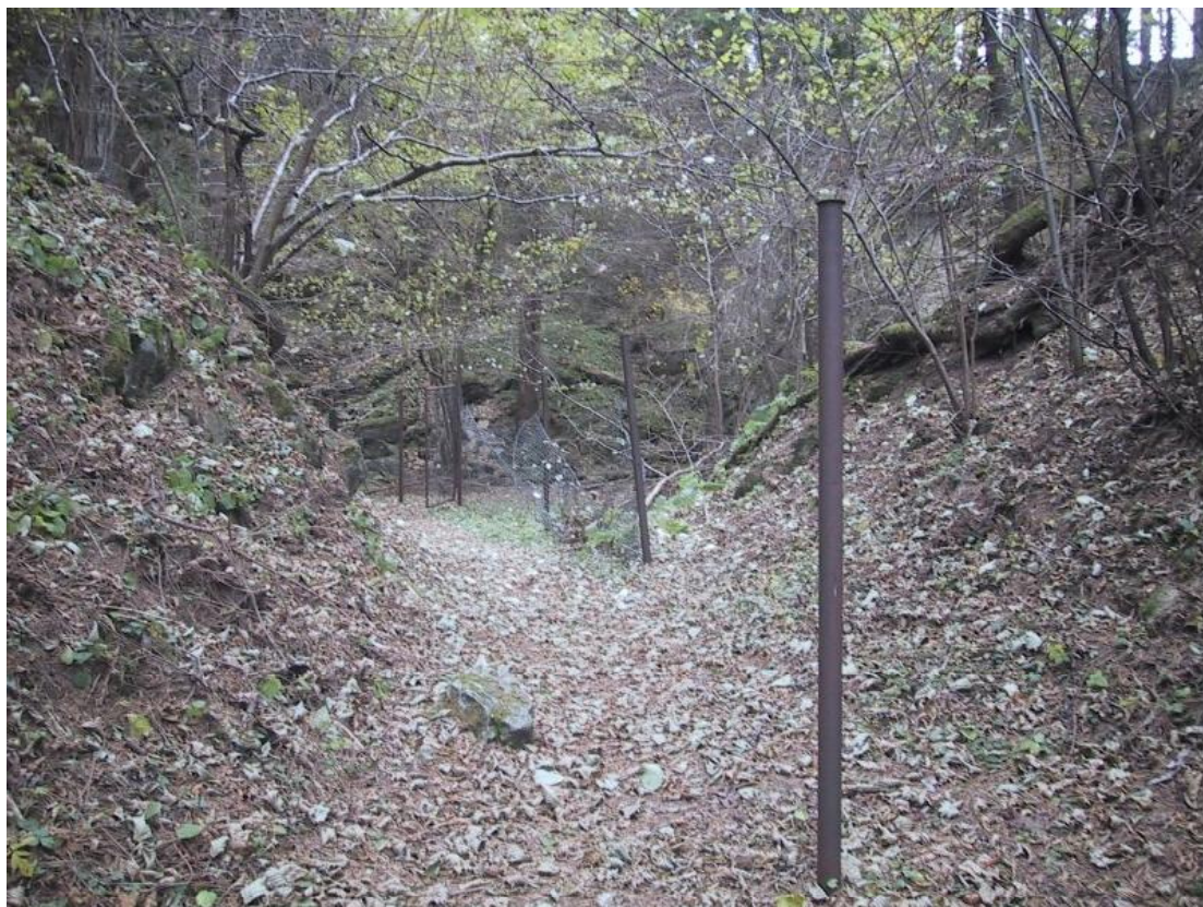
Poškozené a místy chybějící oplocení.
