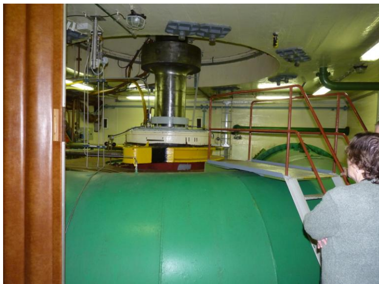
Prohlídka vodní elektrárny. Zde v místě je přívod vody na lopatky vodní turbíny, nahoře nad stropem se nachází generátor. Prostor se nalézá asi 150 m pod hladinou přehrady.
