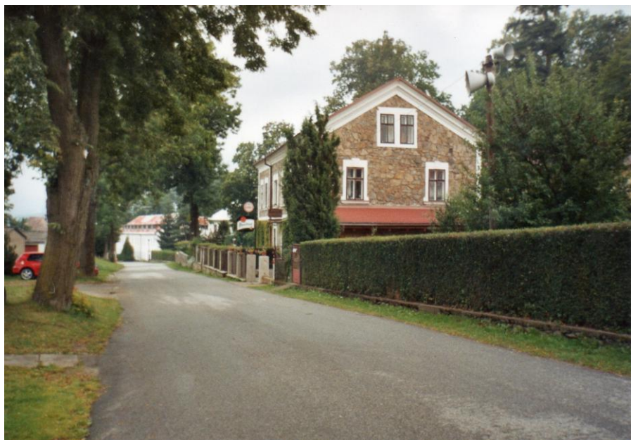
Budova v Horní Plané, kde byl umístěn internát
