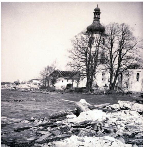
Kostel sv.Linharta bude po odstřelu pomalu zaplavován, voda stoupne až k horním budovám
