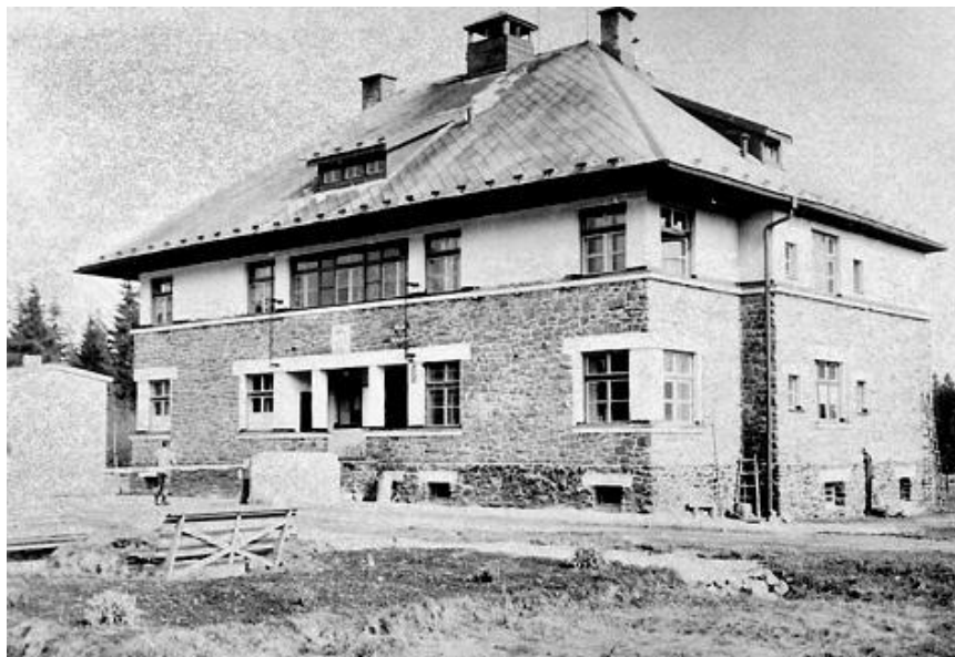
Rota PS na Kyselově, bývalá celnice- foto www.vojensko.cz
