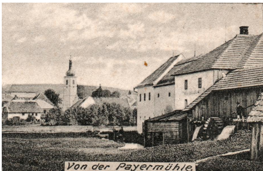
Pohled na Dolní Vltavici od mlýna z osady Kyselov. Mlýn v roce 1929 vyhořel a poté byl přestavěn na pilu. Podruhé vznikl požár v druhé budově v roce 1954.
