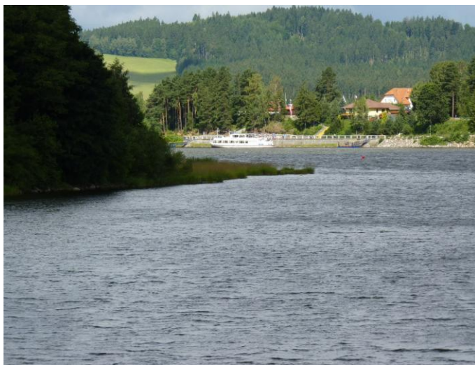
Pohled na dnešní elektrárnu
