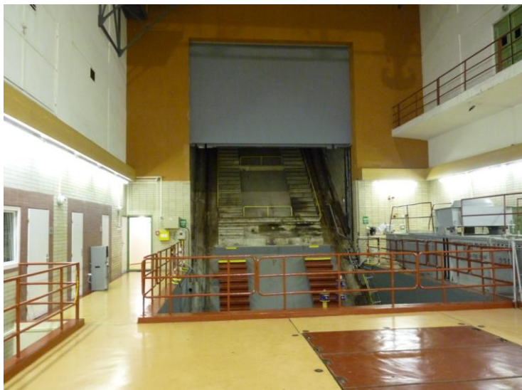
Dolní část šikmé pojezdové dráhy osobního výtahu. Moje návštěva v elektrárně Lipno v roce 2012, kde jsem s dovolením směla fotografovat.
