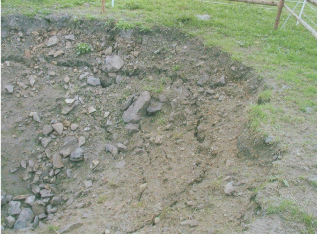
Obr. 4 : Propadnutý terén – detail
