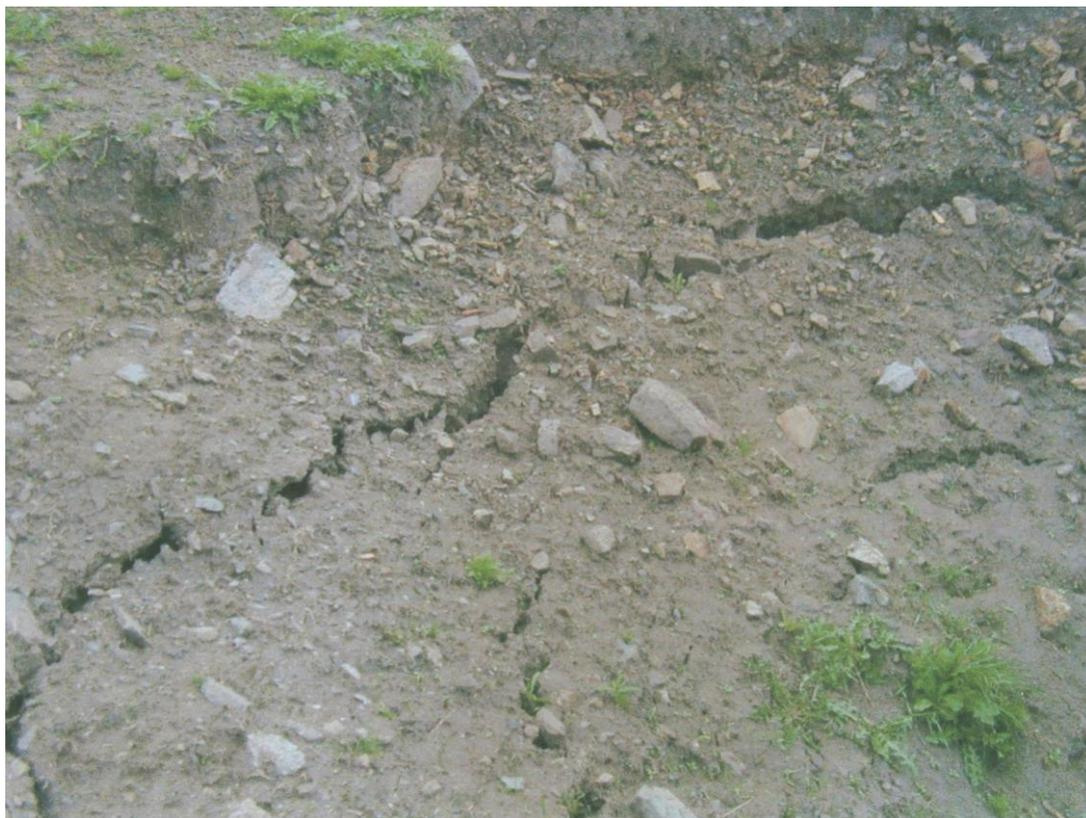
Obr. 6 : Propadnutý terén – detail
