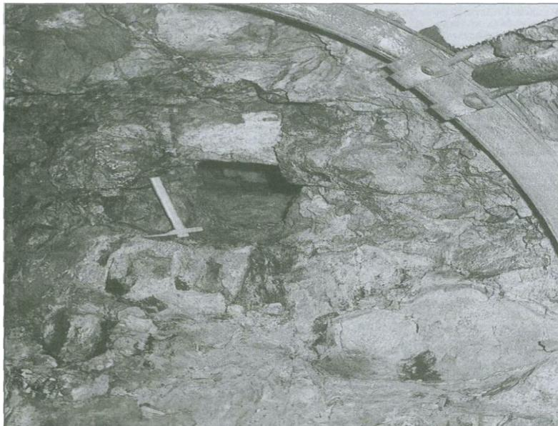
**Obr. 7:** Ústí jedné z krasových dutin tvaru šikmého komína z 2. patra jámy Barbora u Bližné v podložní (východní) grafitové poloze. Při na fáraání této dutiny došlo k průvalu vody v r. 1963, ale přicházely i dříve, hlavně však později, kdy byl na 3. patře dolu zjištěn rozsáhlý kras s jímaným vydatným pramenem kvalitní pitné vody
