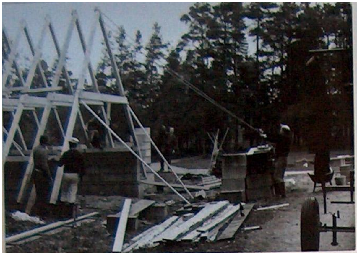
Z výstavby Autokempu Olšina v roce 1986.
