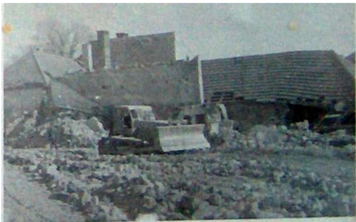
Demolice domů v Bližné
