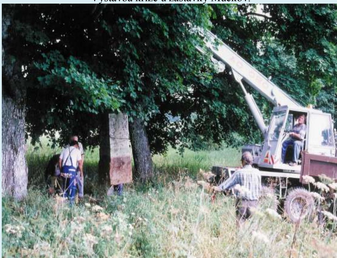
Při stavbě křížů bylo nutno použít i potřebnou mechanizaci – se svým jeřábem pomohl Rudolf Šuran z Černé.
