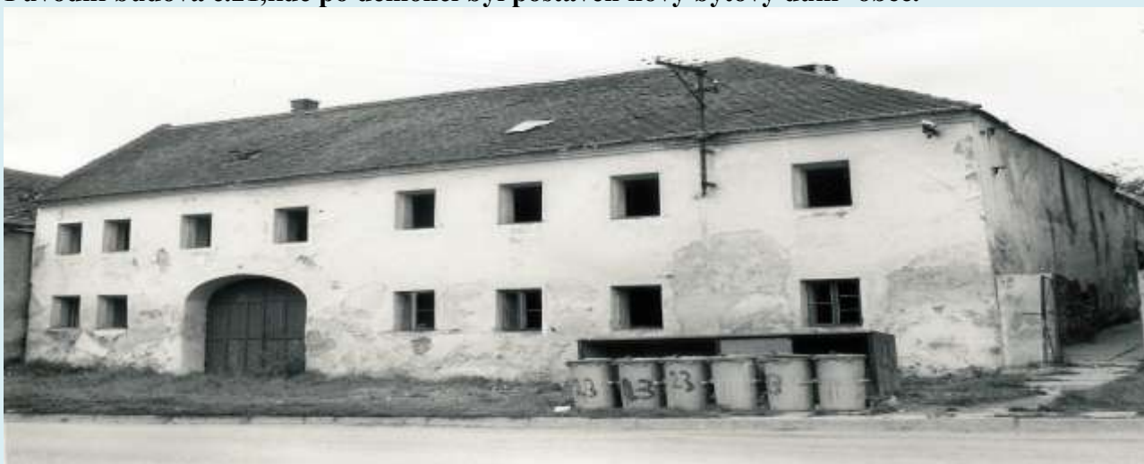
Vedle stojící budova č.22,kde dnes stojí rovněž nový bytový dům/stavěl Statek/.
