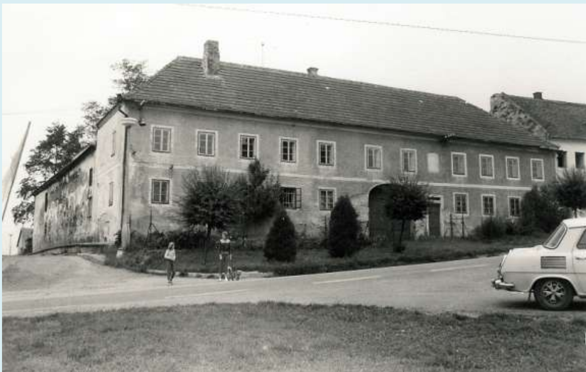
Původní budova č.21,kde po demolici byl postaven nový bytový dům- obec.
