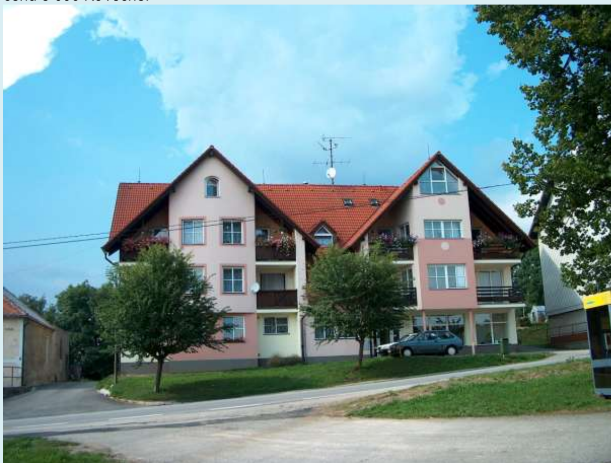
Bytový dům č.21 postavený ve volebním období 1994 – 1998.
