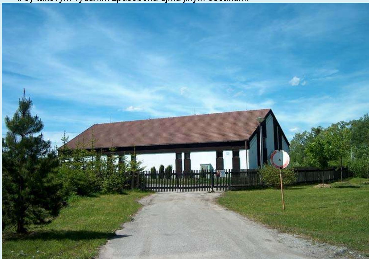
Čistírna odpadních vod v Černé v Pošumaví.
